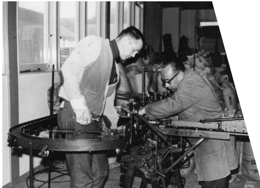
Weltweit erste Maschine zur Herstellung von doppelt abgekröpften Federn
